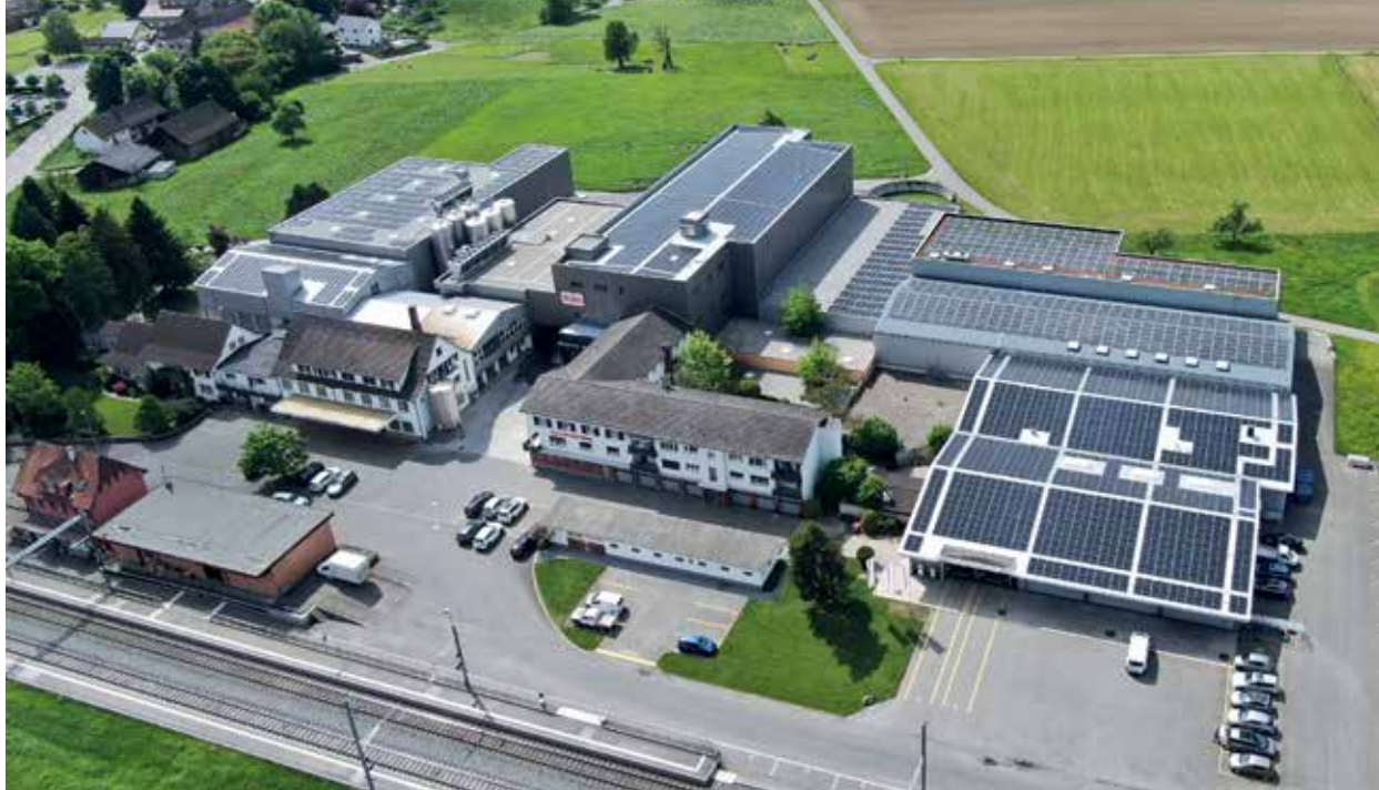
Das Strähl-Solarkraftwerk mit Photovoltaik Eigenverbrauchsanlage an der Bahnhofstrasse 1 in Siegershausen.
